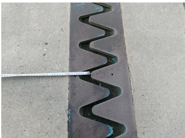
신축이음 여유량 측정
