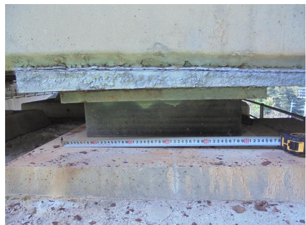
교량받침 이동량 측정
