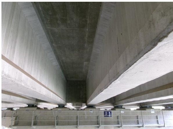
거더 및 바닥판하면 전경
